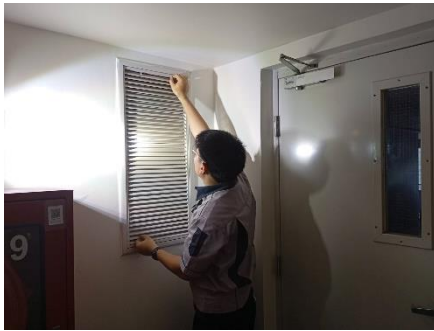
การตรวจสอบหรือนำสิ่งกีดขวางออกจากช่องทางระบายอากาศ
