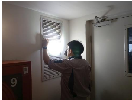
การตรวจสอบหรือนำสิ่งกีดขวางออกจากช่องทางระบายอากาศ
